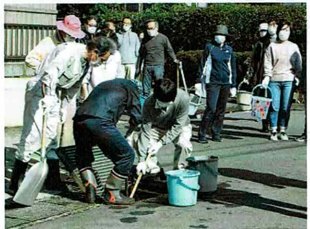
腰痛に注意し交代で雨水枡の土砂を掻き出しています
