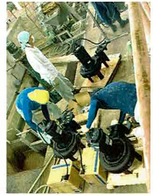
流入ポンプ交換作業
