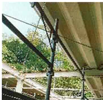
変形スレート板の交換
