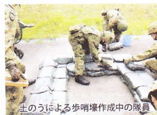
土のうによる歩哨壕作成中の隊員
