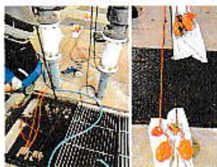
調整槽とフロートスイッチ
