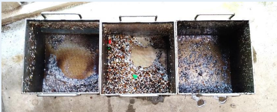
3基の沈殿槽で確認された白いゼリー状物体
