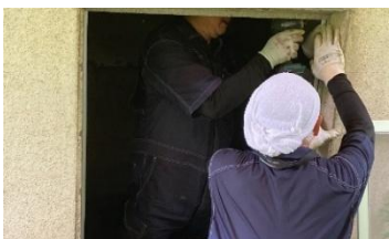
給気口フィルタの取付口、受口加工
