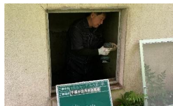
給気口フィルタの取付口、受口加工
