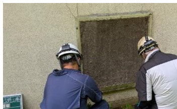
作業用仮フィルター設置
