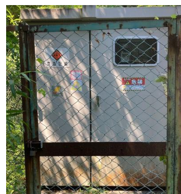
受電設備 高圧・低圧系統の点検
