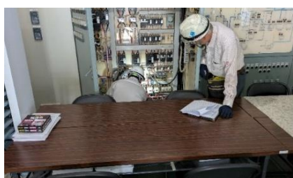
汚水処理制御盤の点検
