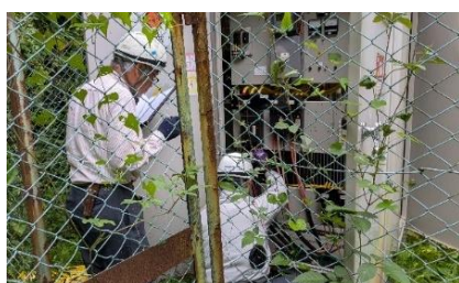
受電設備 高圧・低圧系統の点検
