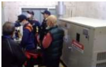
発電機室の点検
