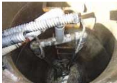
(b) 仮設ポンプ配管による応急復旧
