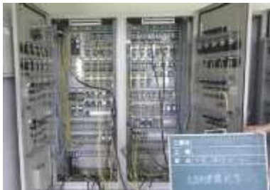
(a) 仮設制御盤の設置
