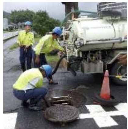
ポンプ車による汚水引き抜き
