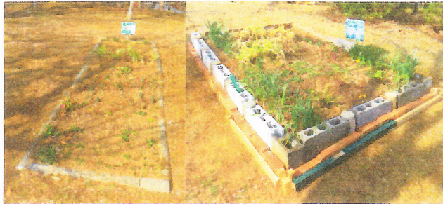
中央公園遊歩道花壇枠 2か所完成
