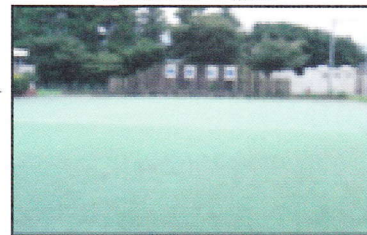
青空広場の補修
