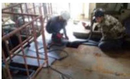
穴まわりの張替え作業
