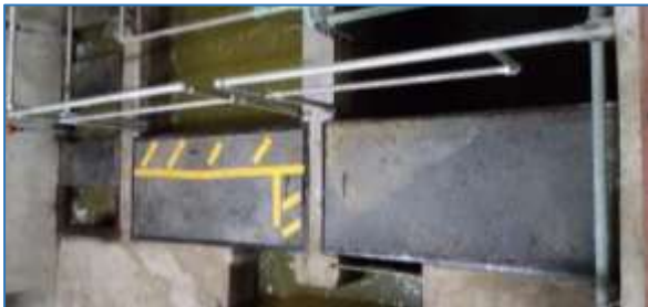
沈砂槽の足まわり
