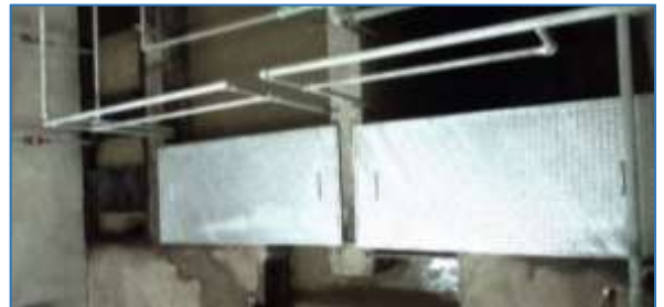
腐食に強い亜鉛メッキ板に交換
